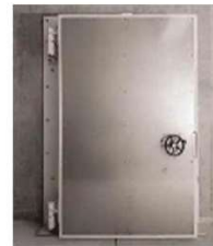
防水扉の設置
