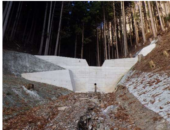
令和元年完成 釜石市駒木地区
