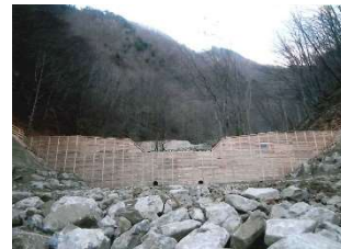
【治山:溪間工(治山ダム)】
