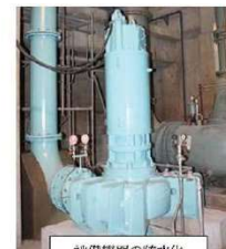
設備機器の防水化(耐水型モーター)
