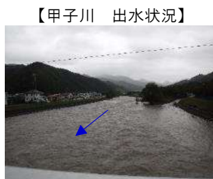
令和元年台風第19号 甲子川流域被害状況
