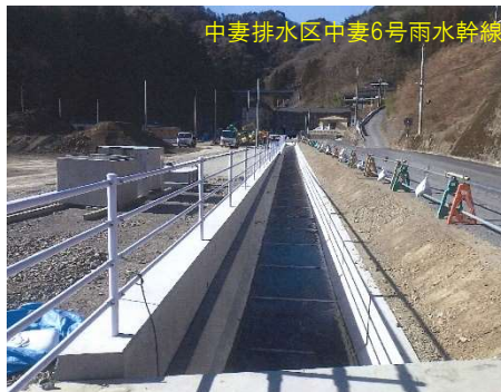
暗渠を開渠化
