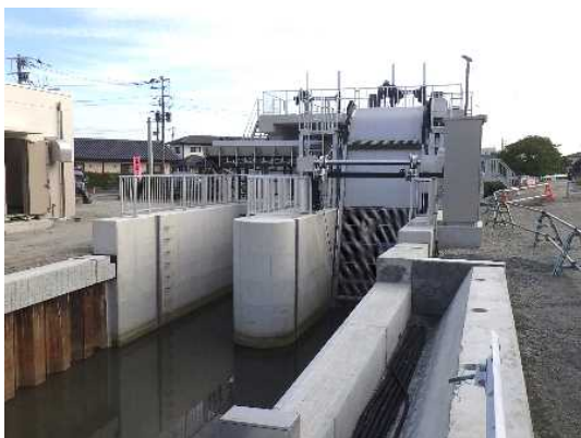
雨水ポンプ場の整備
