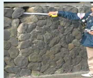
擁壁の危険度調査
