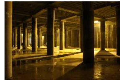
貯留施設の整備
