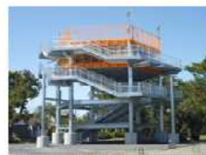
津波避難タワー
