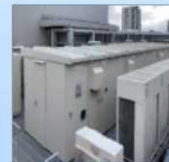
電気設備の設置場所の高上げ
