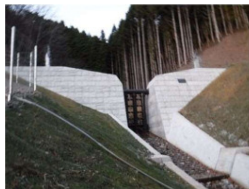
砂防堰堤完成事例
