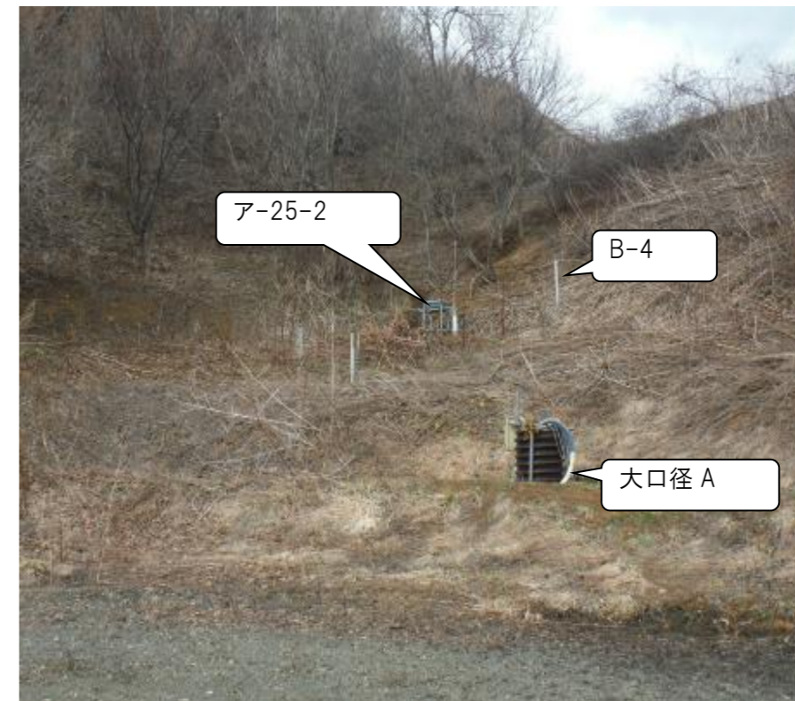
図3 B-4周辺 現況
