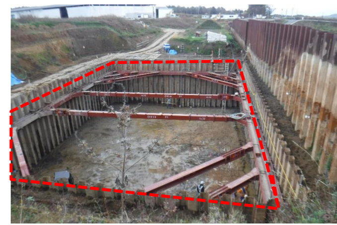
図12 イ-24及び1号集水井周辺 掘削後
