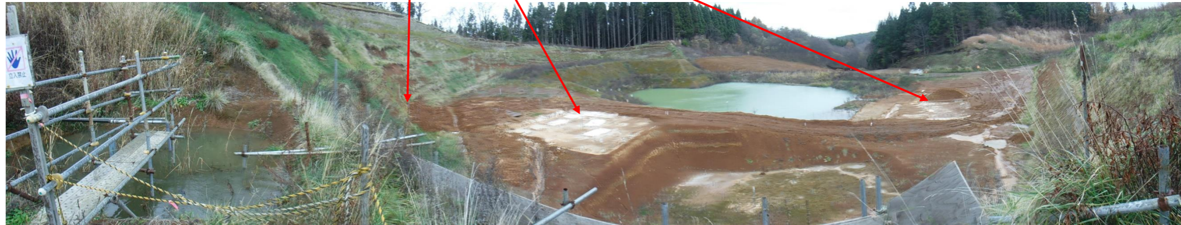
図 16 区域⑨ 施工後
