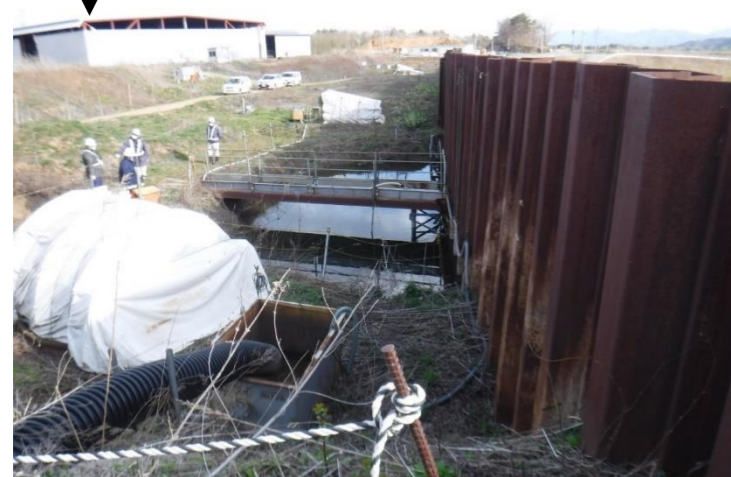
図10 イ-24及び1号集水井周辺 掘削前
