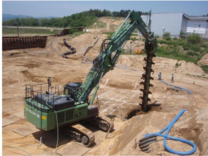
図3 N地区におけるパワーブレンダー工法（H28.5.23撮影）
