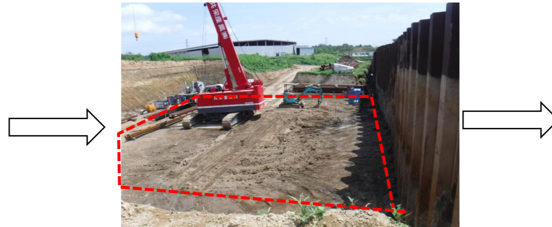
図11 イ-24及び1号集水井掘削除去の準備工 (点線は掘削予定範囲)
