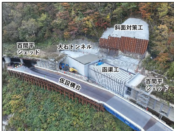
【起点側坑口（北上市側）施工状況10月末】
