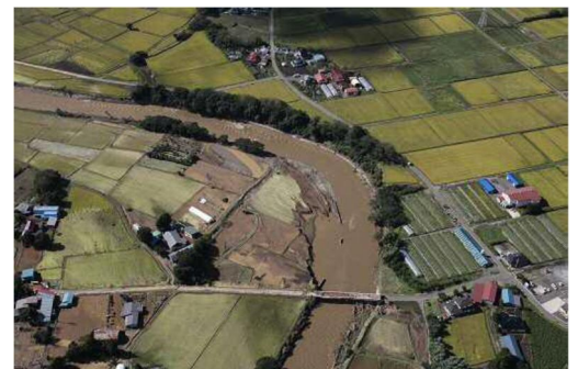
被災状況（平成25年9月 松川）
