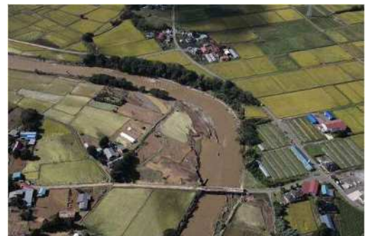
被災状況(平成 25 年 9 月 松川)
