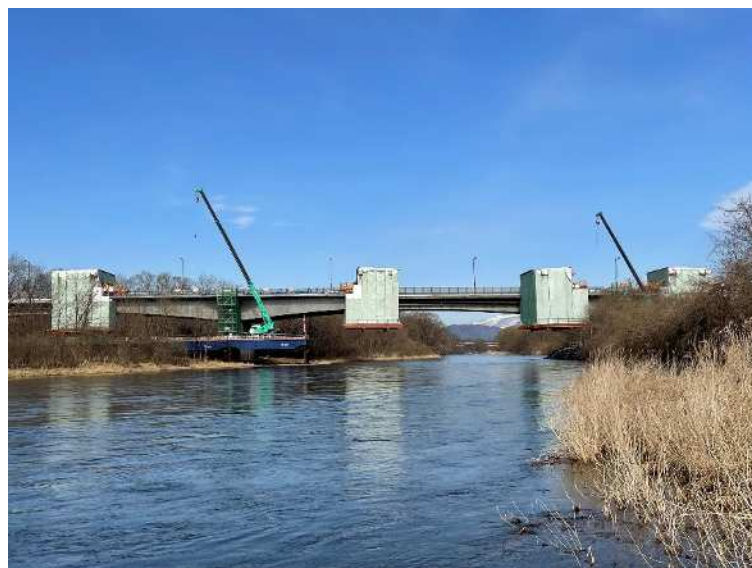
上部工施工状況（令和5年3月撮影）
