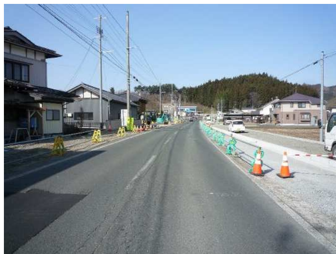
起点から終点を望む(令和5年3月撮影)
