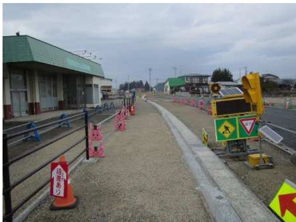
道路改良（一般国道 456 号終点側から望む）
