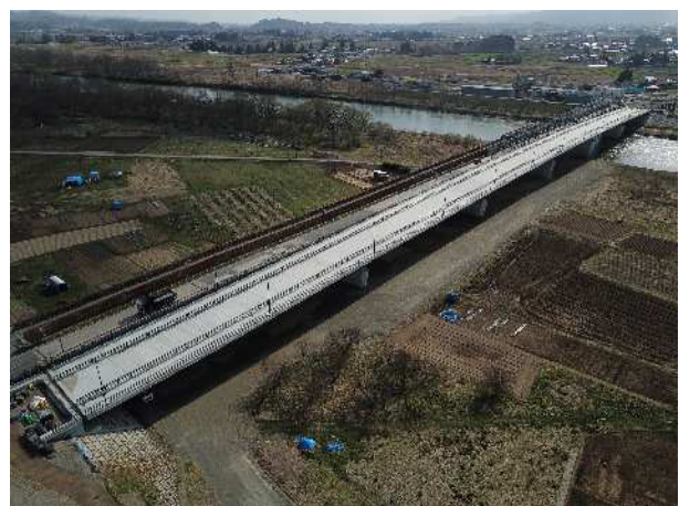
上部工施工状況（令和5年3月撮影）
