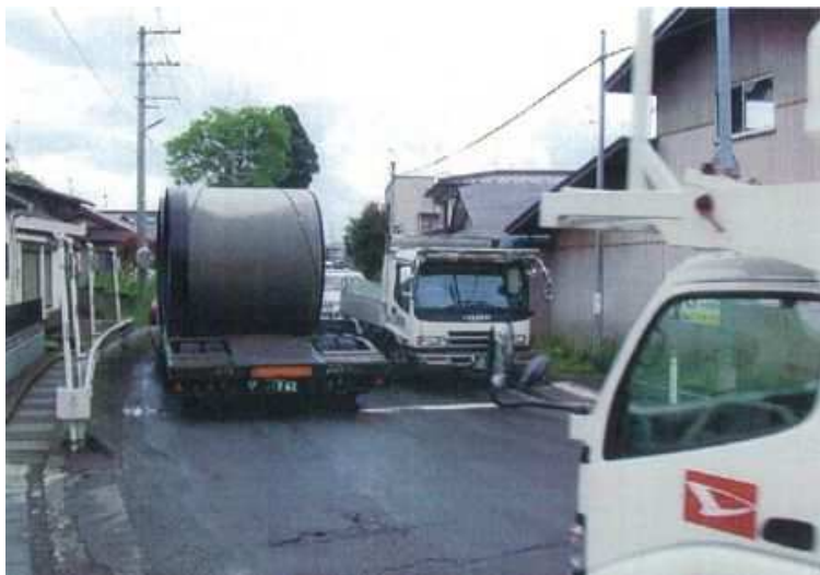
【起点から未供用区間を望む（令和5年3月撮影）】
