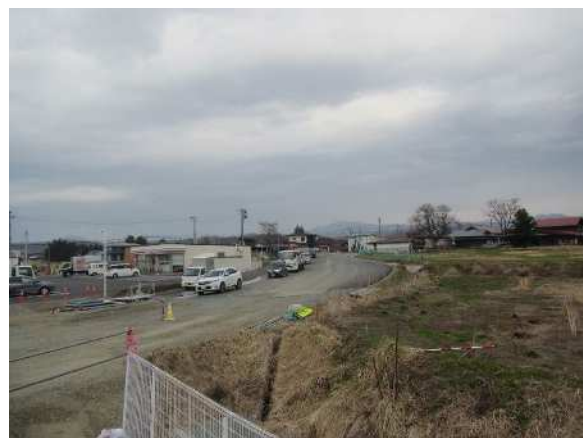
道路改良（紫波江繫線起点側から望む）
