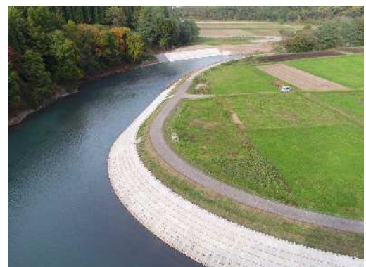
令和 3 年度松川整備状況(令和 3 年 11 月)
