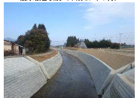
完成区間状況 (令和3年3月)
