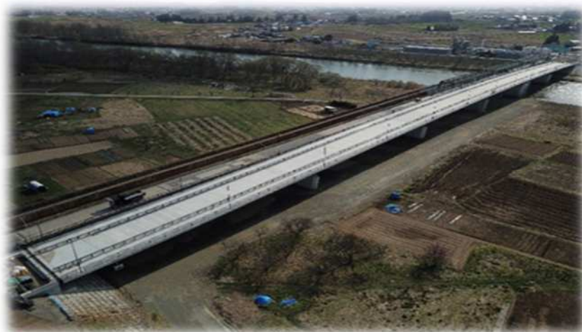
一般県道大ヶ生徳田線 徳田橋（建設中）（盛岡市～矢巾町）
