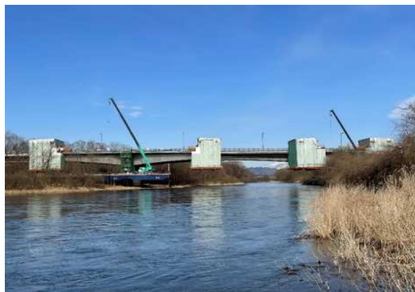
【都市計画道路盛岡駅本宮線】 盛岡市 杜の大橋 (撮影: 令和5年3月)
