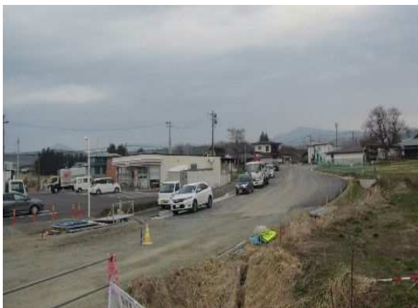
【主要地方道紫波江繫線】 紫波町星山地区 (撮影: 令和5年3月)
