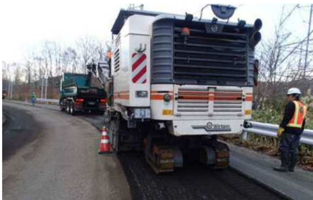
道路舗装の補修
