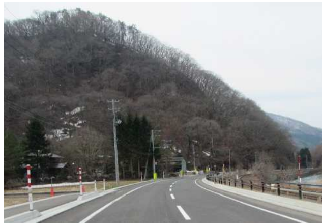
【一般国道282号】 八幡平市佐比内地区 (撮影: 令和5年4月)
