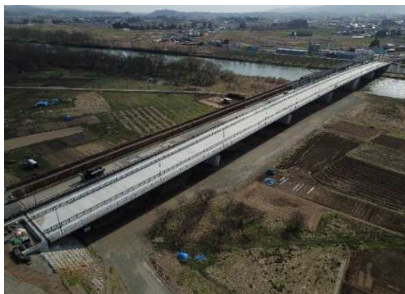
【一般県道大ヶ生徳田線】 盛岡市～矢巾町 徳田橋 (撮影: 令和5年3月)
