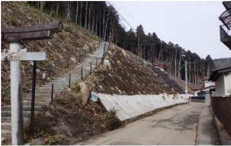
山岸地区急傾斜地崩壊対策(盛岡市) (撮影: 令和4年3月)
