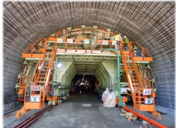
館下トンネル覆エコンクリート施工 (2020/6/15)
