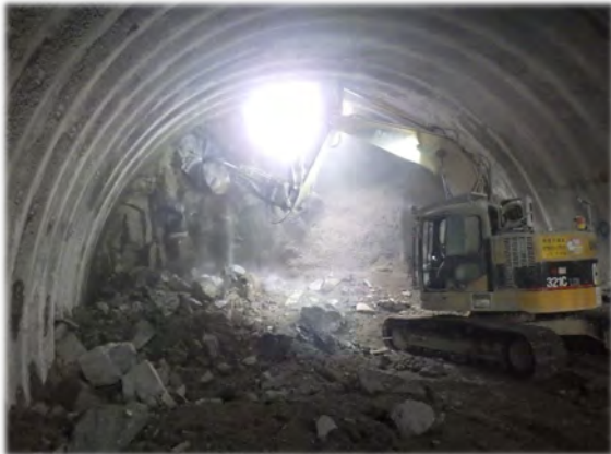
館下トンネル貫通 (2020/4/18)
