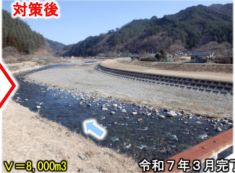
河道掘削量  $V=8,000\text{m}^3$
