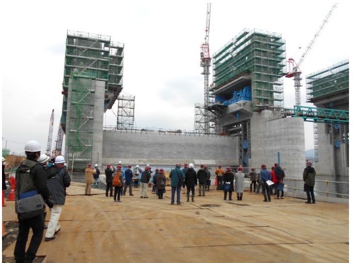
▲水門ゲート据付を直前に控えた水門の状況を間近で見学いただきました
