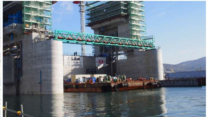
▲宮古に到着した水門ゲートの吊り上げ作業の様子
