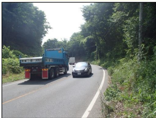
▲整備前：幅員が狭く歩道がない
