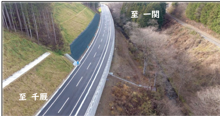
▲整備後：幅員を確保し歩道を整備
