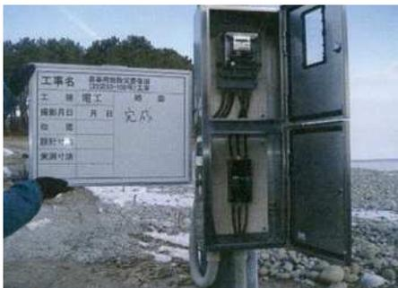
施工状況 (引込開閉器盤設置)
