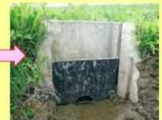
水戸板設置状況
