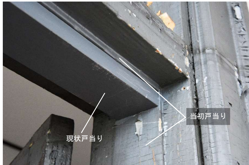
図 59 1階縦覧室出入口扉の戸当り状況 当初の扉開閉はホール側ではなく室内側であることが分かる。
