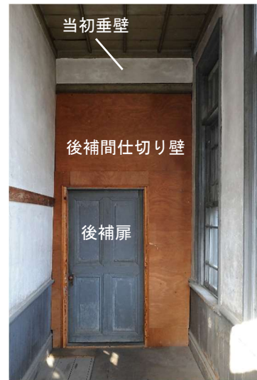
図 62 東側廊下北面の状況
