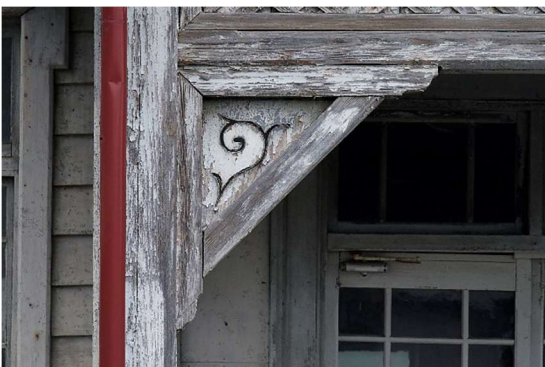
図 35 玄関ポーチ正面持送り
