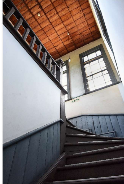
図 22 階段室 見上げ
