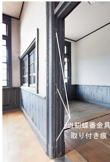
図 58 1階縦覧室出入口扉の 当初蝶番金具取り付け痕
