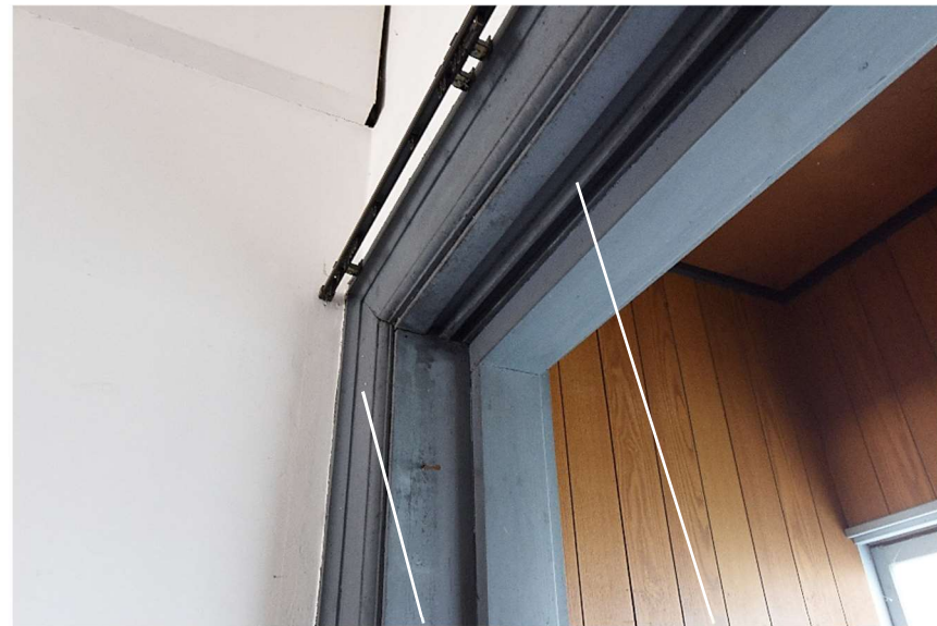
図 52 1階ホール東 面に残る二溝 鴨居と建具枠
