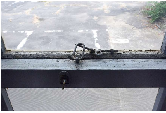
図 42 上げ下げ窓戸締め金具
