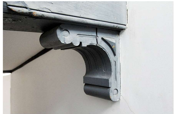
図 46 階段室壁受け持送り
