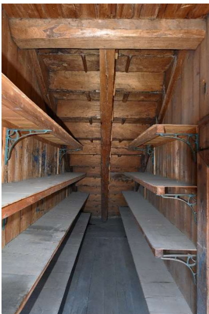
図 19 階段下倉庫 北面見通し
