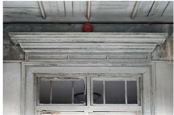
図 34 玄関扉口上部
