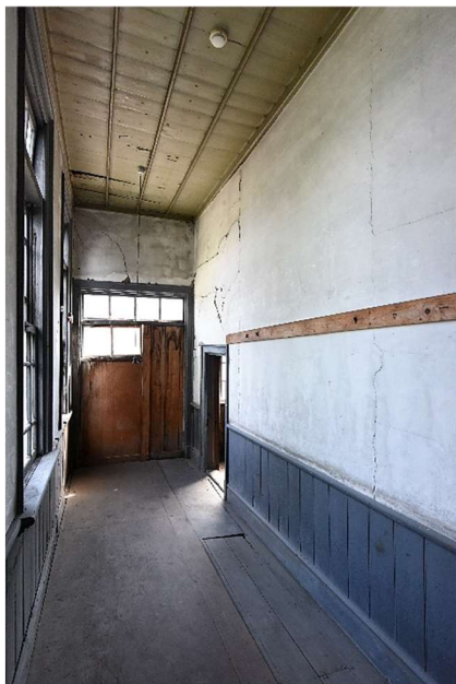
図 17 東側廊下 南面見通し
