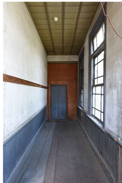
図 18 東側廊下 北面見通し
