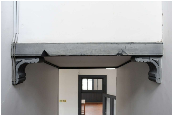
図 45 階段室壁受け廻り
