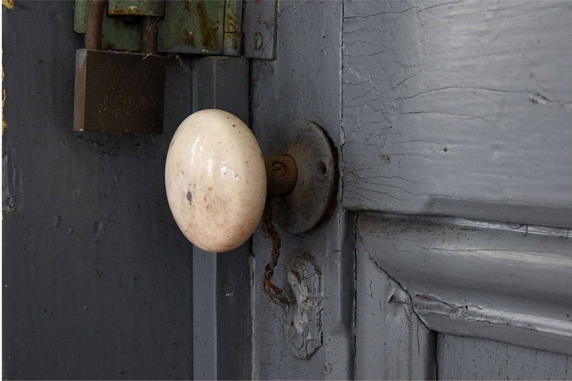
図 44 1階第5会議室東面扉ノブ 瑠璃製
