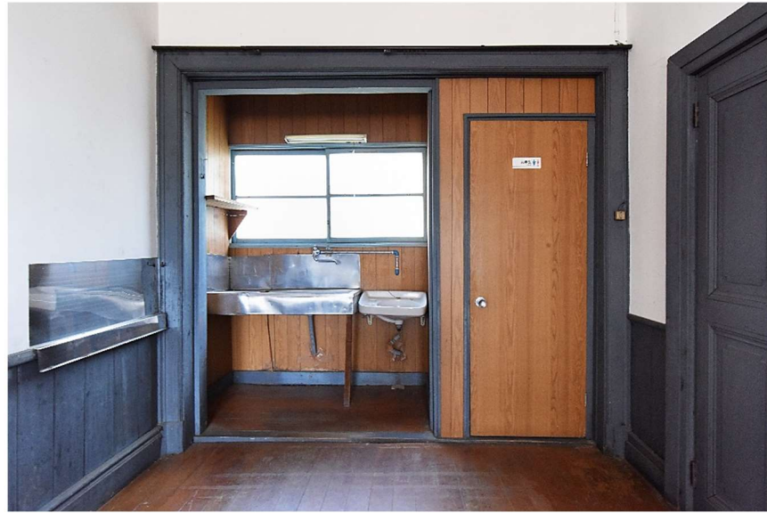
図 51 1階ホール東 面流し場廻り
