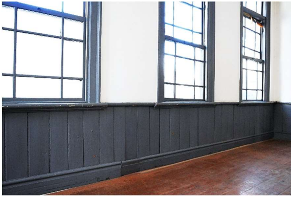
図 54 1階第5会議室北面腰板壁廻り
