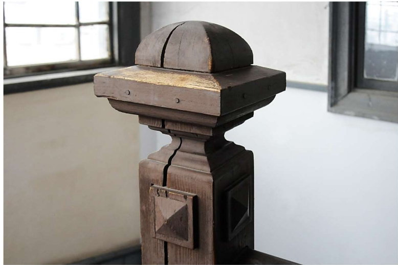
図 48 階段室手摺親柱詳細
