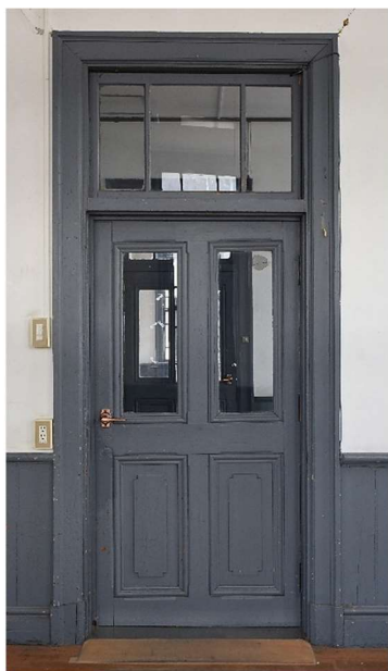
図 39 1階第5会議室南面扉口
