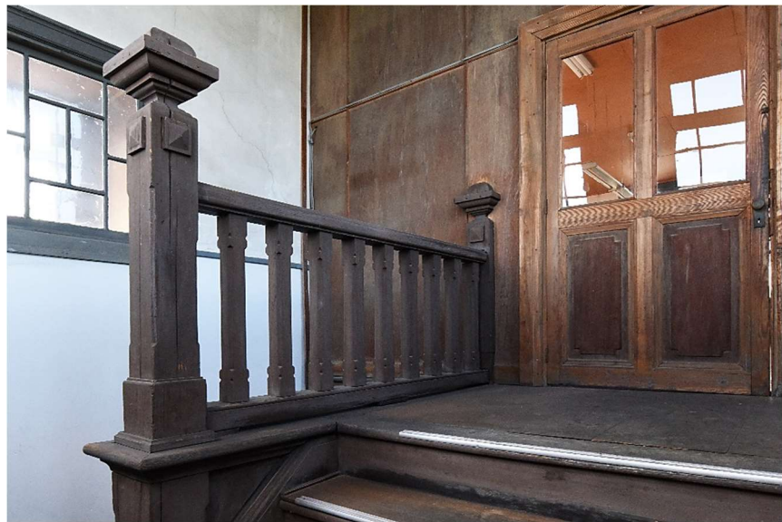
図 63 階段室 2 階大 会議室出入口 廻り 各手摺子は 材が新しい。
