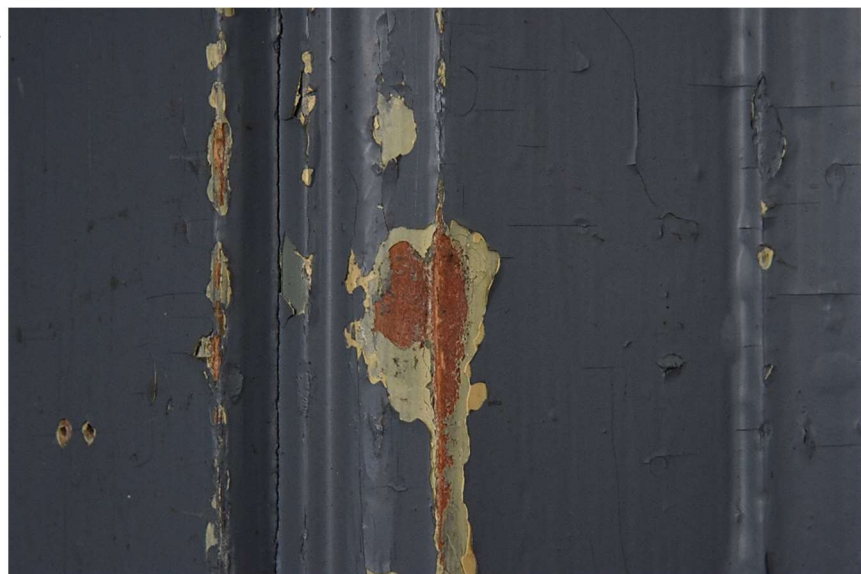
図 50 1階第5会議室 東面建具枠の 塗装状況 現状塗装 下に旧塗装 層が残る。
