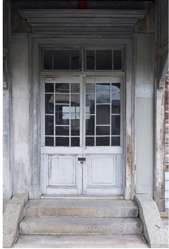
図 32 正面玄関廻り
