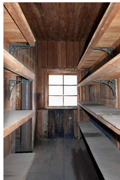
図 20 階段下倉庫 南面見通し
