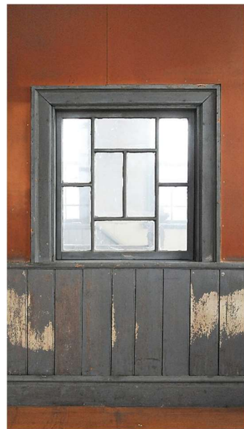
図 41 2階職員室南面窓
