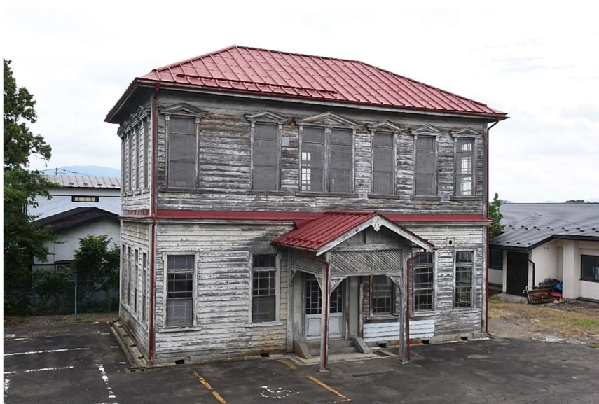
图5 正侧面全景 (西北面)
