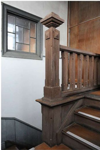
図 47 階段室手摺廻り
