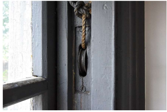
図 43 上げ下げ窓装置
