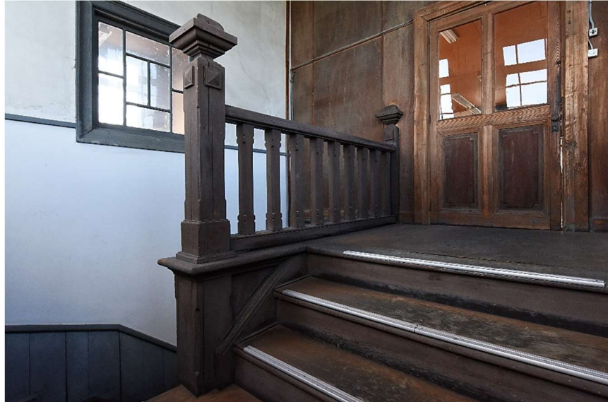
図 23 階段室 2階出入口廻り
