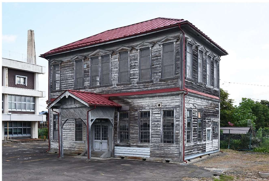
图4 正侧面全景 (西南面)
