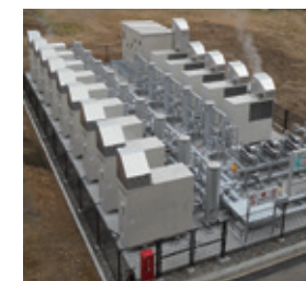
ガスエンジン発電設備
