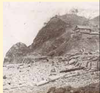
島越・沢村地区(昭和三陸大津波)
