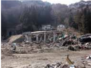
倒壊した駅舎と橋脚
