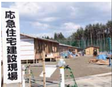
仮設住宅の建設が進む(平成23年7月頃)
