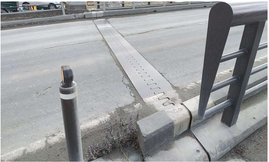
○工事着手前(伸縮装置交換工)
