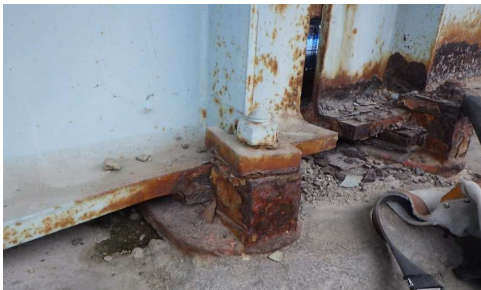
○工事着手前(P8支承補修工)
