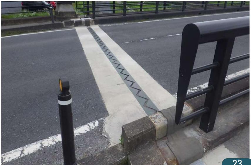
○工事完成(伸縮装置交換工)
