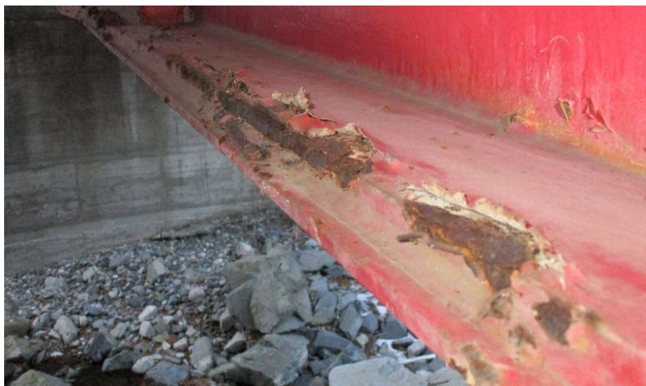
○工事着手前(塗装塗替工)
