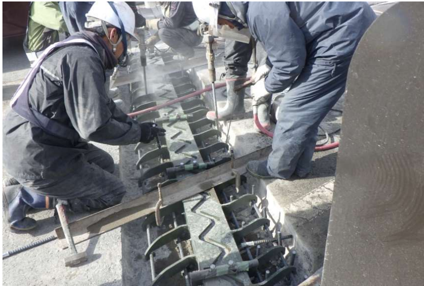
○工事完成(伸縮装置交換工)
