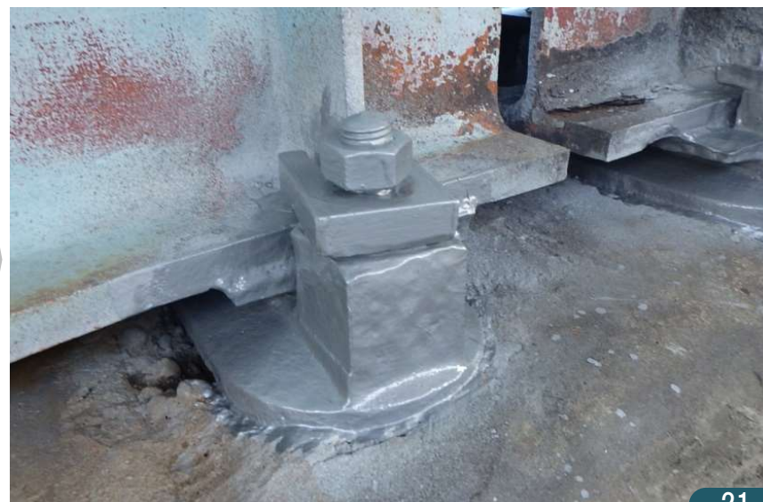
○工事完成(P8支承補修工)
