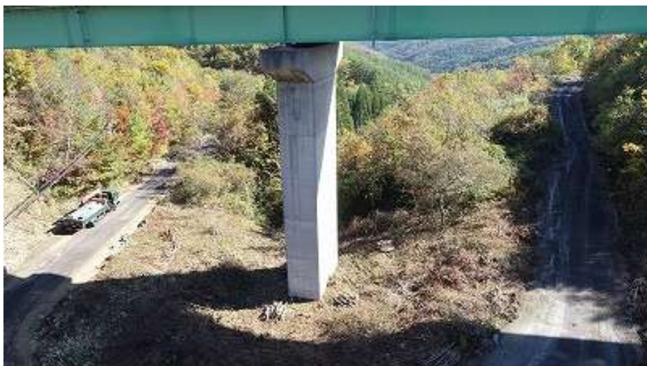
○工事着手前(P1 橋脚巻立工)
