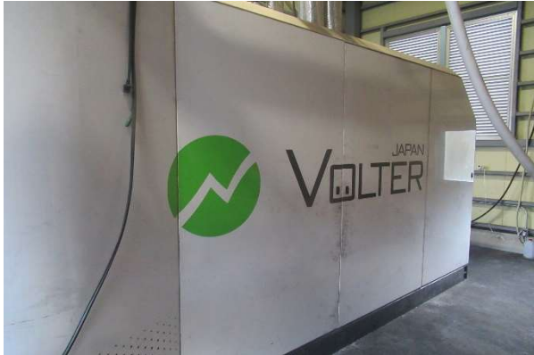
【県内に導入された木質バイオマス熱電併給装置】
