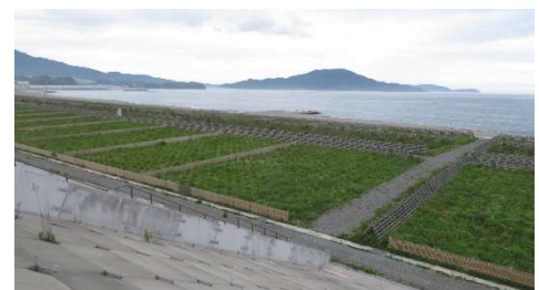
【防潮林の再生の状況（高田松原地区）】
