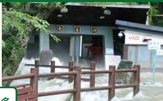
平成28年台風10号により、龍泉洞の通路が水没。 写真提供:岩泉町
