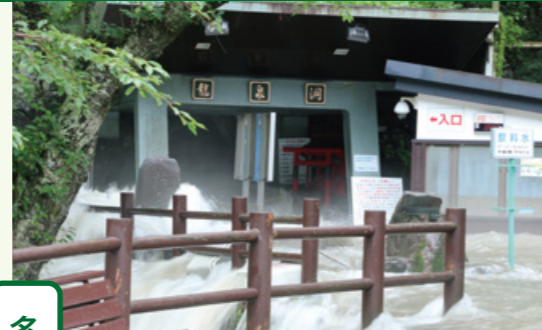
平成28年台風10号により、龍泉洞の通路が水没。 写真提供:岩泉町
