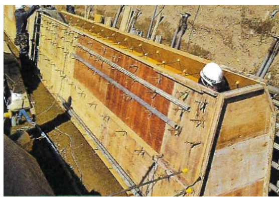
法枠工 (二級河川長内川筋川崎地区護岸工ほか工事)
