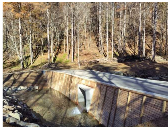
コンクリート擁壁に使用した木製残存型 枠工(盛岡森林管理署)
