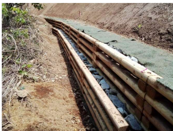
林道法面の崩落等を防ぐ木製土留め工 (盛岡森林管理署)
