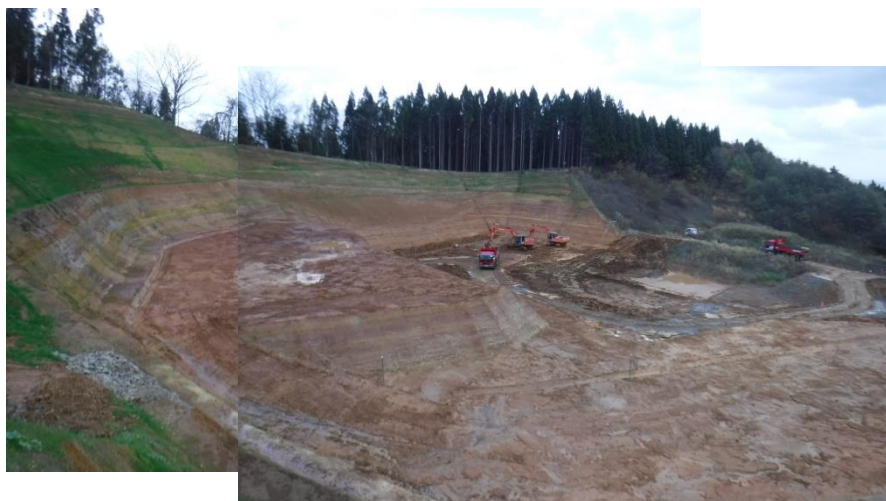
図 2-5 B地区北側法面の掘削完了状況（令和元年10月30日撮影）
