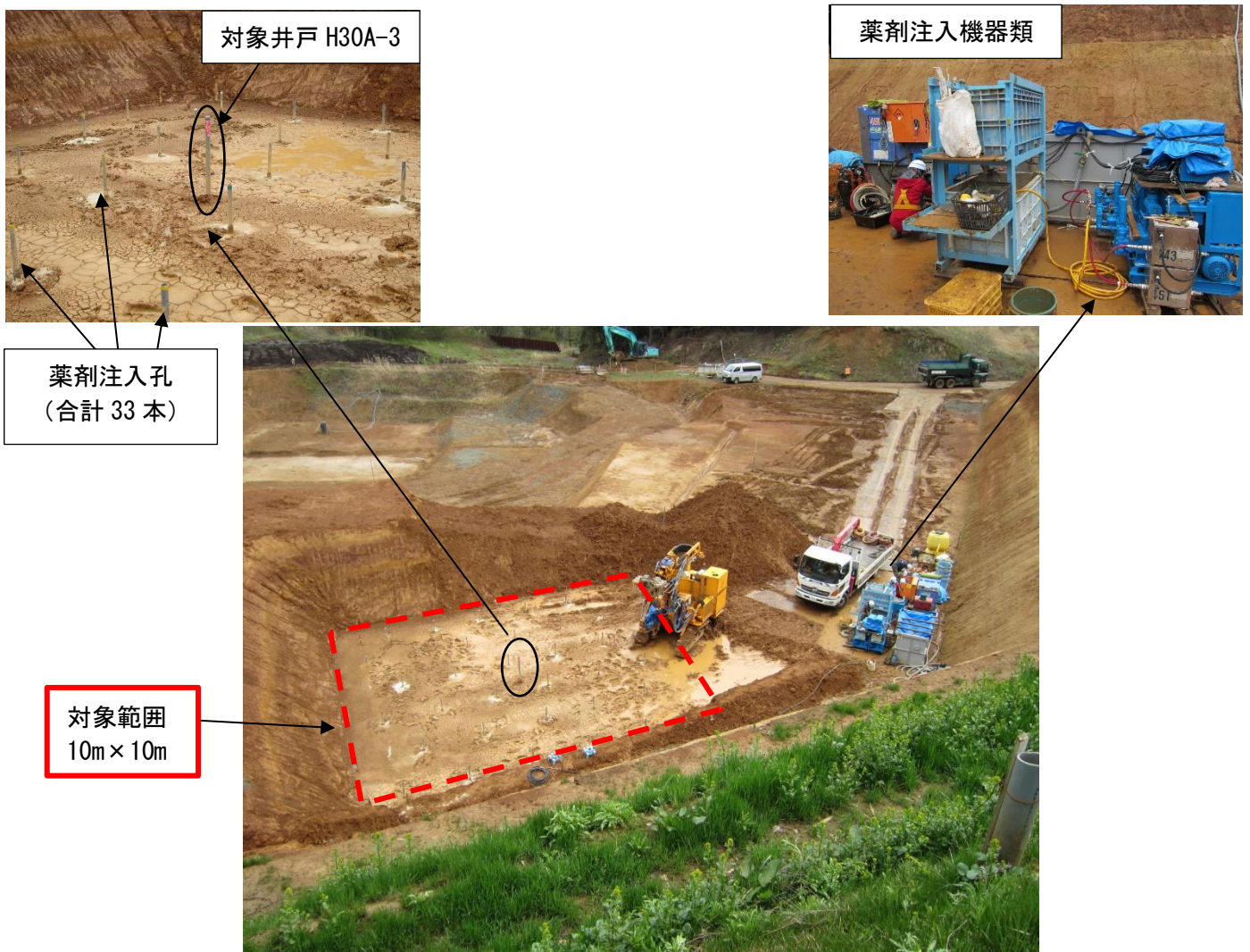
図 2-4 薬剤処理工（パイロット試験） 注入孔設置状況写真（令和 2 年 5 月 7 日撮影）
