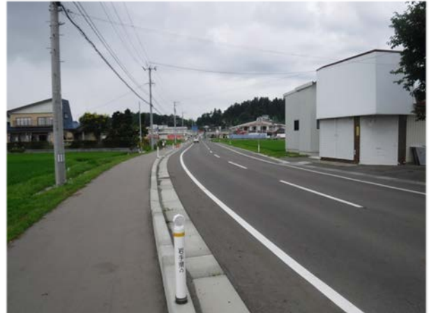
安全確保のため歩道を設置 一般国道283号 花巻市前郷地区
