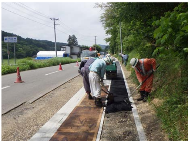
主要地方道二戸田子線 二戸市小平地区の施工状況
