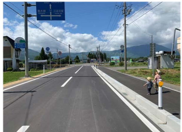
今年の6月に完成した 一般県道雫石東八幡平線 雫石町長山地区
