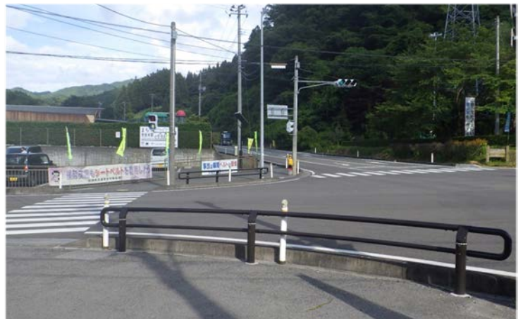
車両の侵入防止のため防護柵を設置 一般国道107号 住田町火石地区
