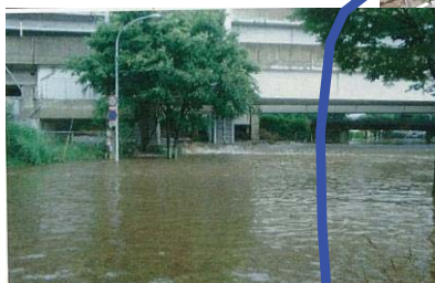
②平成14年7月11日浸水状況
