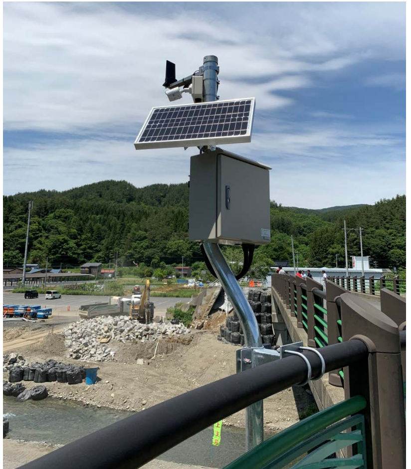
設置状況（小本川ふれあい橋（岩泉町））
