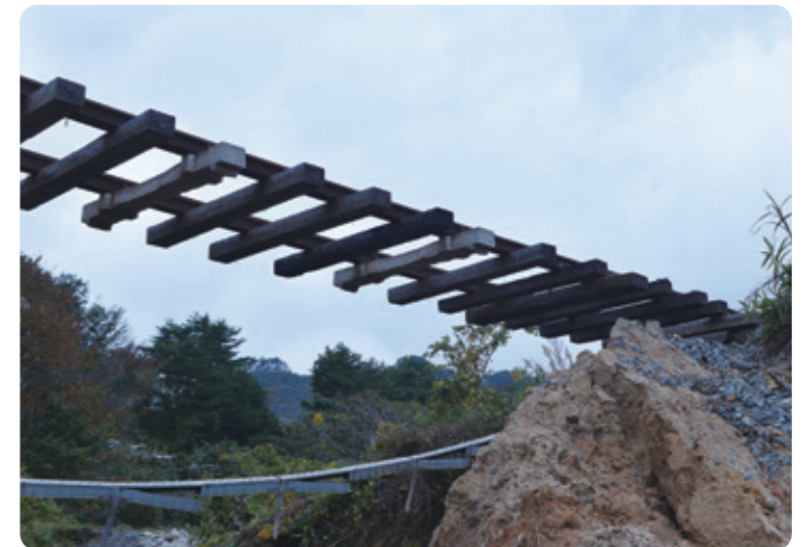
台風の被害で宙にういてしまった線路 山田町船越地区
