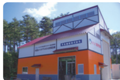
木質バイオマスガス化発電
