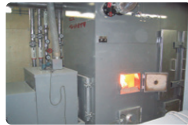
ペレットボイラー
