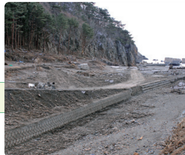
被災後(2011(平成23)年3月23日)
