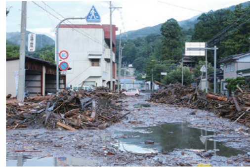
台風上陸の翌朝、国道455号岩泉橋付近
