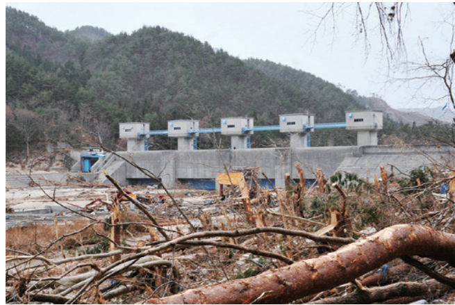
被災直後の普代水門
