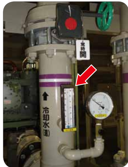
冷却水出口温度計確認
