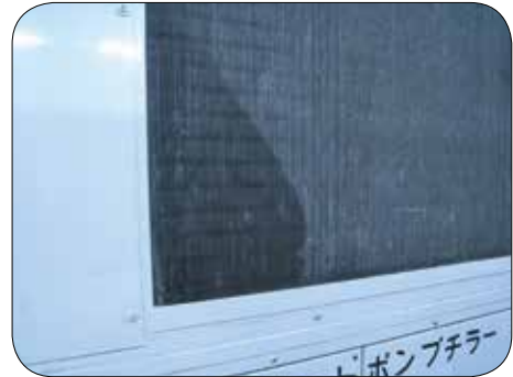
熱交換器の油のにじみ
