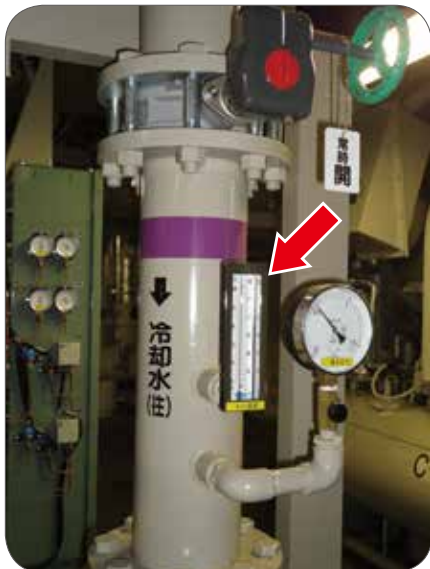
冷却水入口温度計確認
