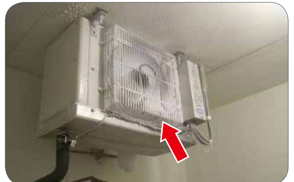
冷却器の内部霜付き異常
