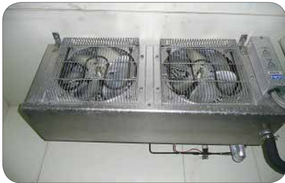
冷蔵庫内正常な冷却器外観
