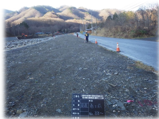
安家橋上流左岸(県道)着手前
