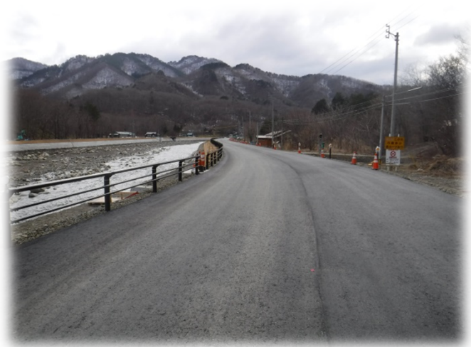
安家橋上流左岸(県道)現況 (県道嵩上げ工事)
