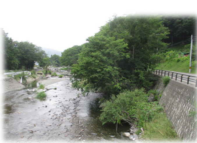
大正橋上流左岸着手前
