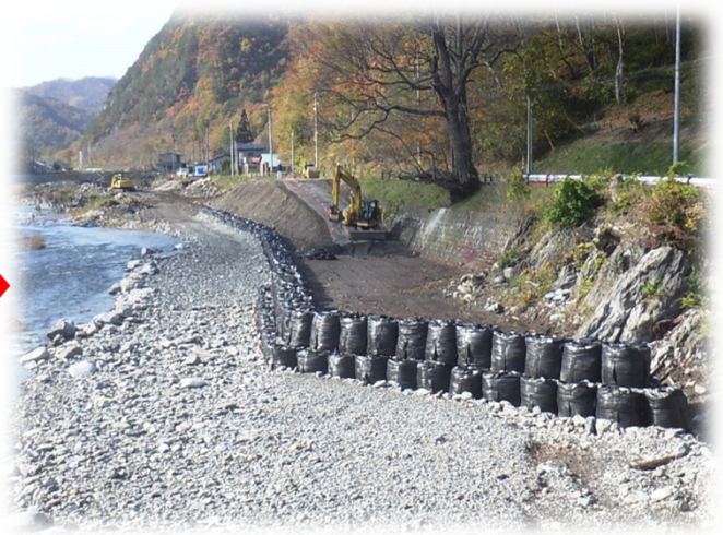
大正橋上流左岸現況 (大正橋橋台施工のための締切)
