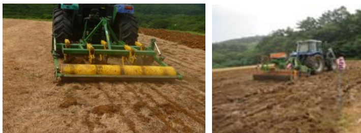
写真 施工状況 (左: 硬盤破碎(サブソイラ)、右: 表層攪拌(ディスクハロー))
