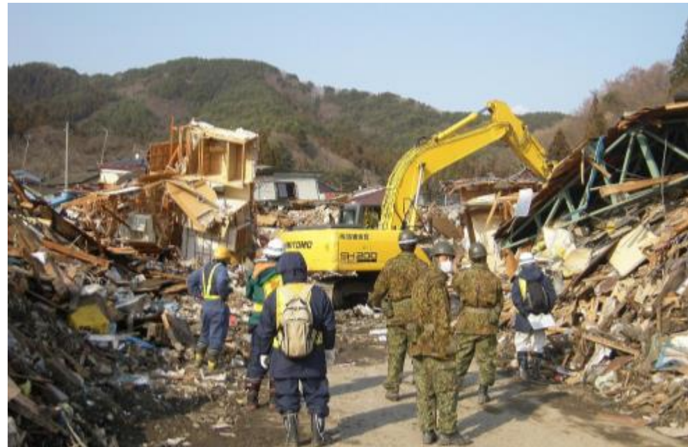
大槌町安渡小学校へ向かう道路の啓開作業 けいかい
