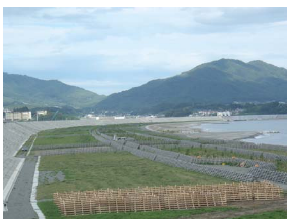
高田松原の復旧状況（R元.8 現在）
