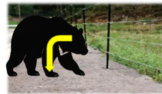
恒久電気柵と鉄鋼スラグ舗装を組み合わせた省力的な管理技術
