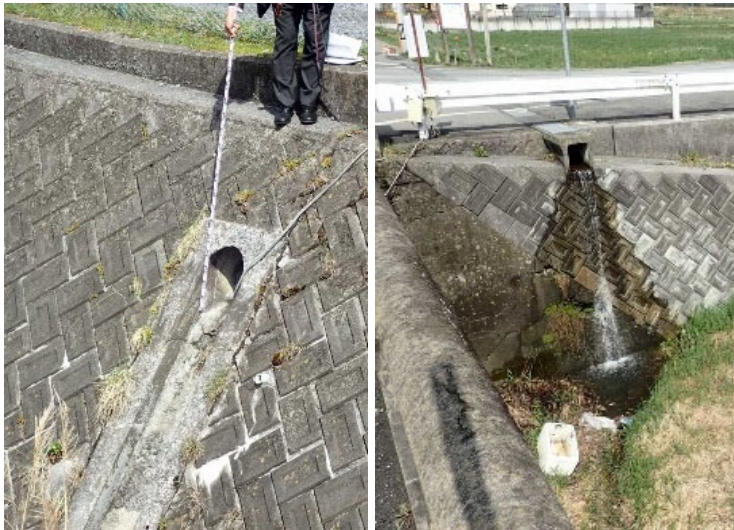
現況の排水吐口部付近
