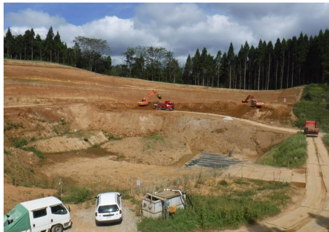
写真：北側法面の掘削状況
