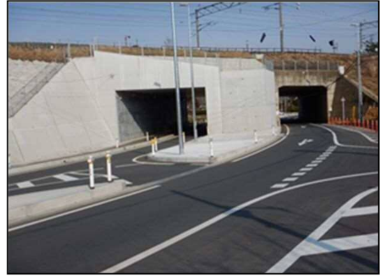
写真① (整備後)
