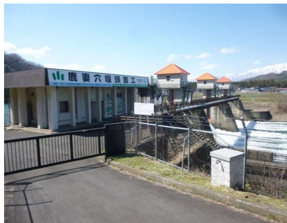
【鹿妻穴堰頭首工】
