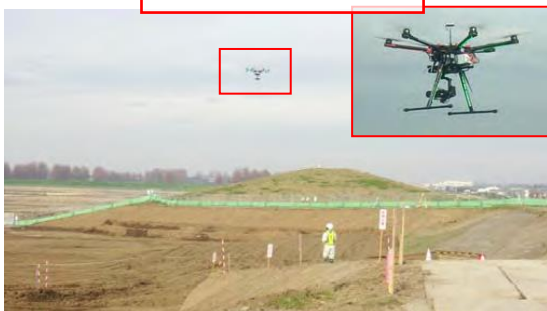
①UAVによる測量状況
