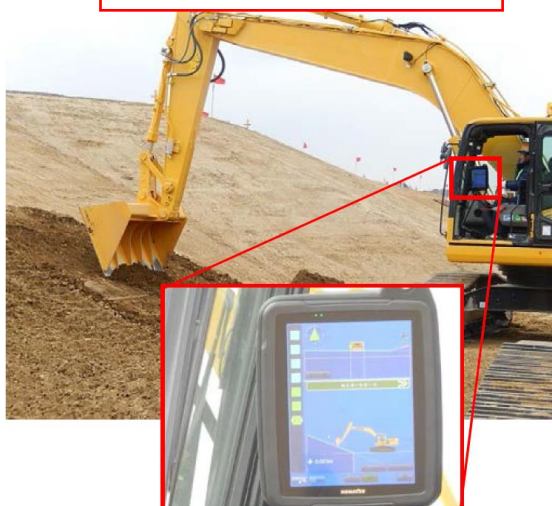
③マシンガイダンスによる施工状況
