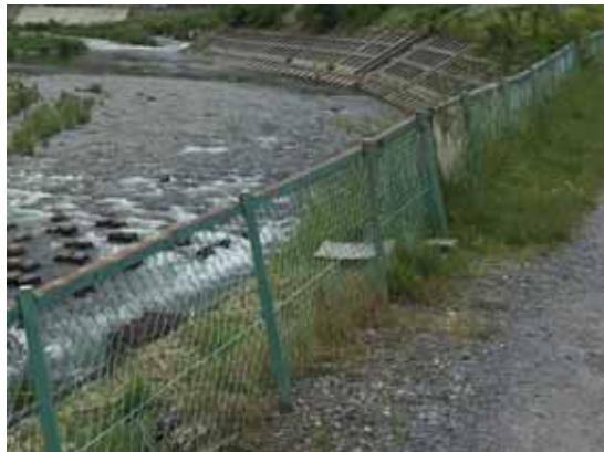
現況の緑色フェンス
