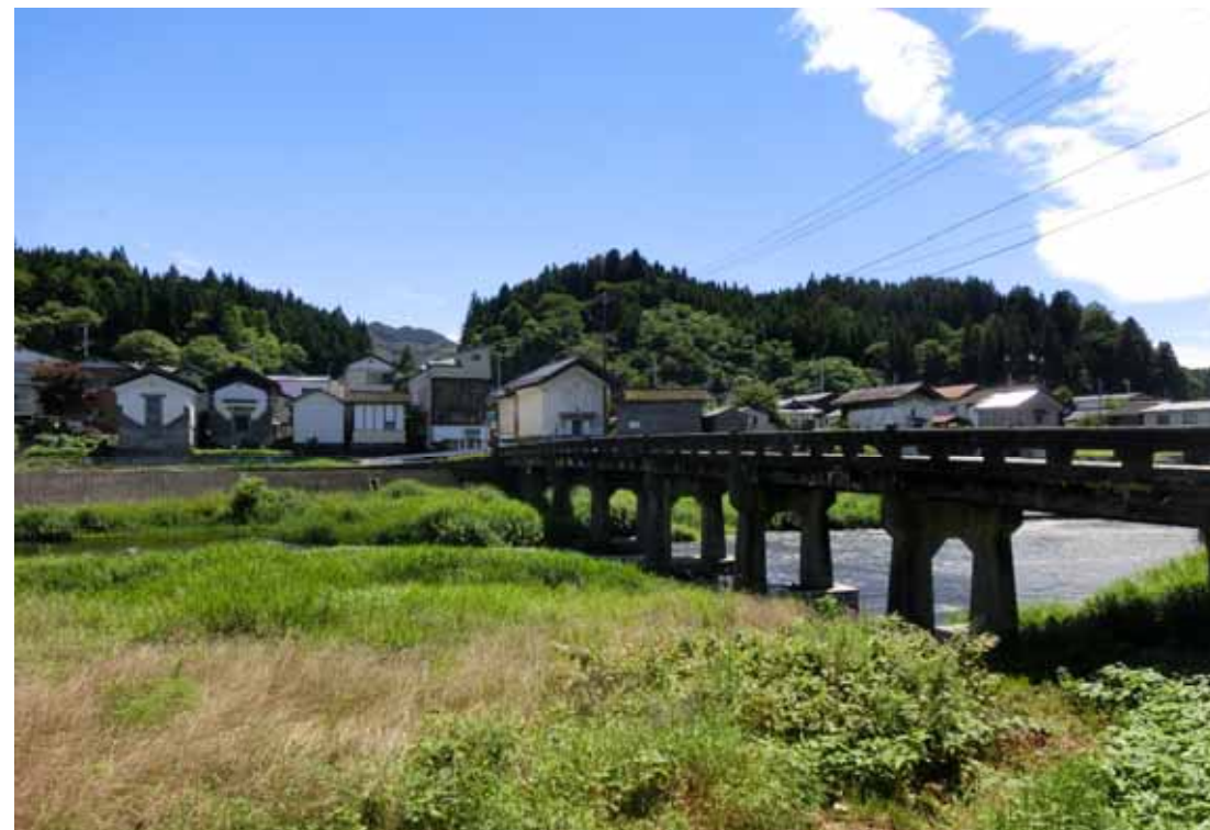
昭和橋の上空を跨ぐ架空線
