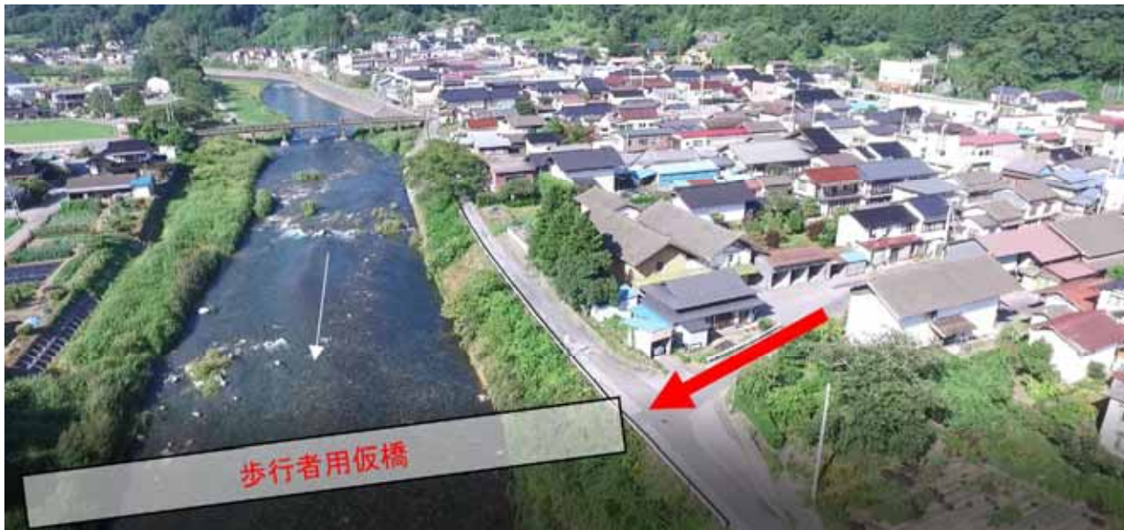
昭和橋工事中の歩行者仮橋
