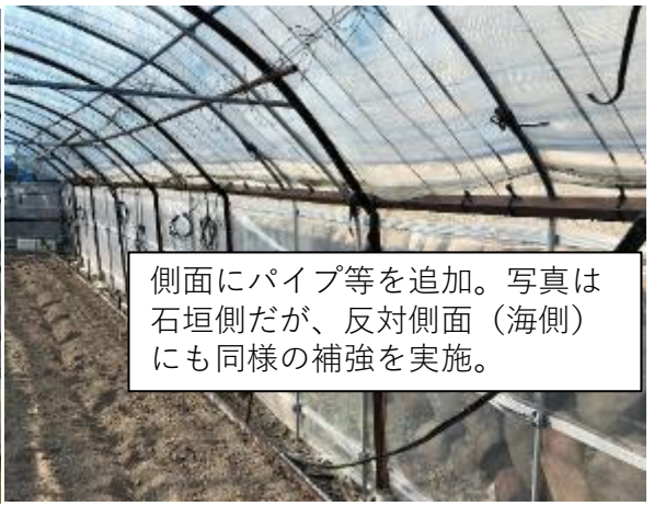
側面の補強（強風対策）
