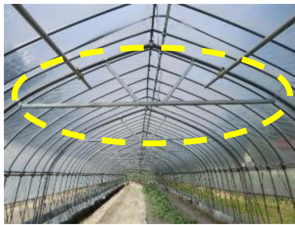
タイバーの設置による補強
