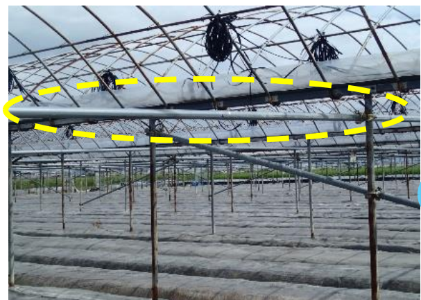
タイバーの設置による補強
