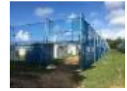
防風ネットの設置
