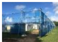
防風ネットの設置
