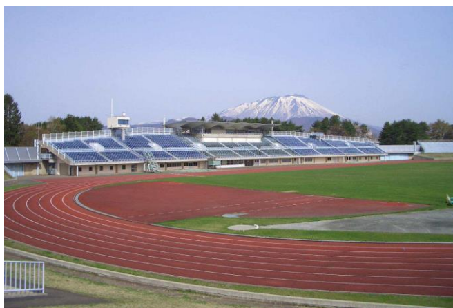
<岩手県営運動公園陸上競技場>
