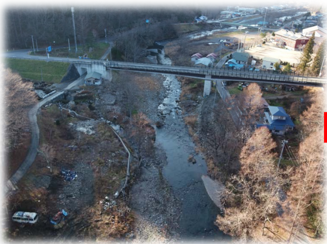
安家ほたる橋付近着手前
