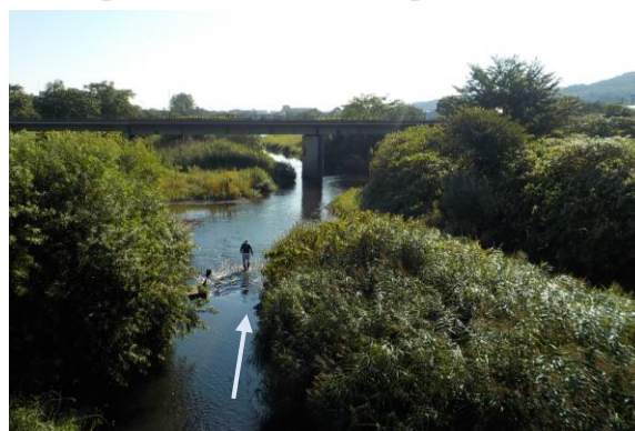
【長内川：長内橋下流】
