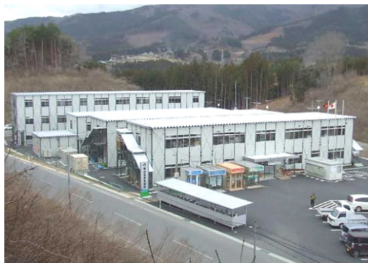
陸前高田市仮設庁舎
