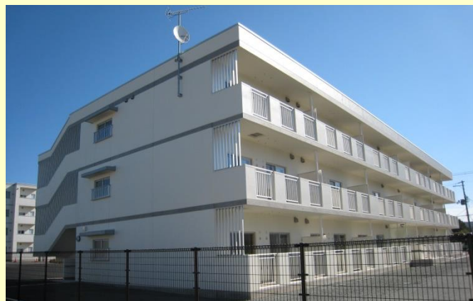
県営備後第1アパート(盛岡市):平成30年9月完成
