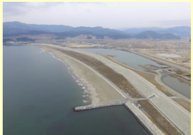
高田海岸の砂浜再生工事の状況(H31.2月時点)
