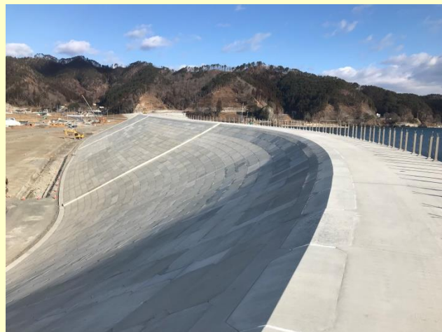
片岸海岸(釜石市):平成30年12月整備完了
