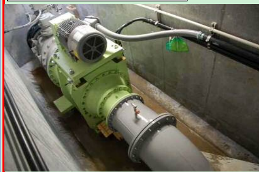
小水力発電所（水車・発電機）写真
