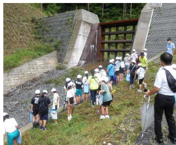
↑小学校裏にある砂防堰堤を見学しました
