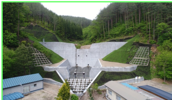
↑上乙茂の沢(4)砂防堰堤完成（令和2年5月撮影）
