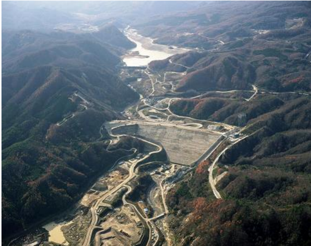
建設中の国土交通省胆沢ダム。河川維持流量を利用した発電所として、企業局が胆沢第三発電所を建設します。(1,500kW、平成 26 年度運転開始予定) 平成 21 年 11 月国土交通省胆沢ダム工事事務所撮影
