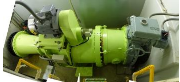
北ノ又第三発電所の水車発電機。 既設発電所の導水路の未利用落差エネルギーを活用するものです。(61kW、平成 22 年 2 月運転開始)
